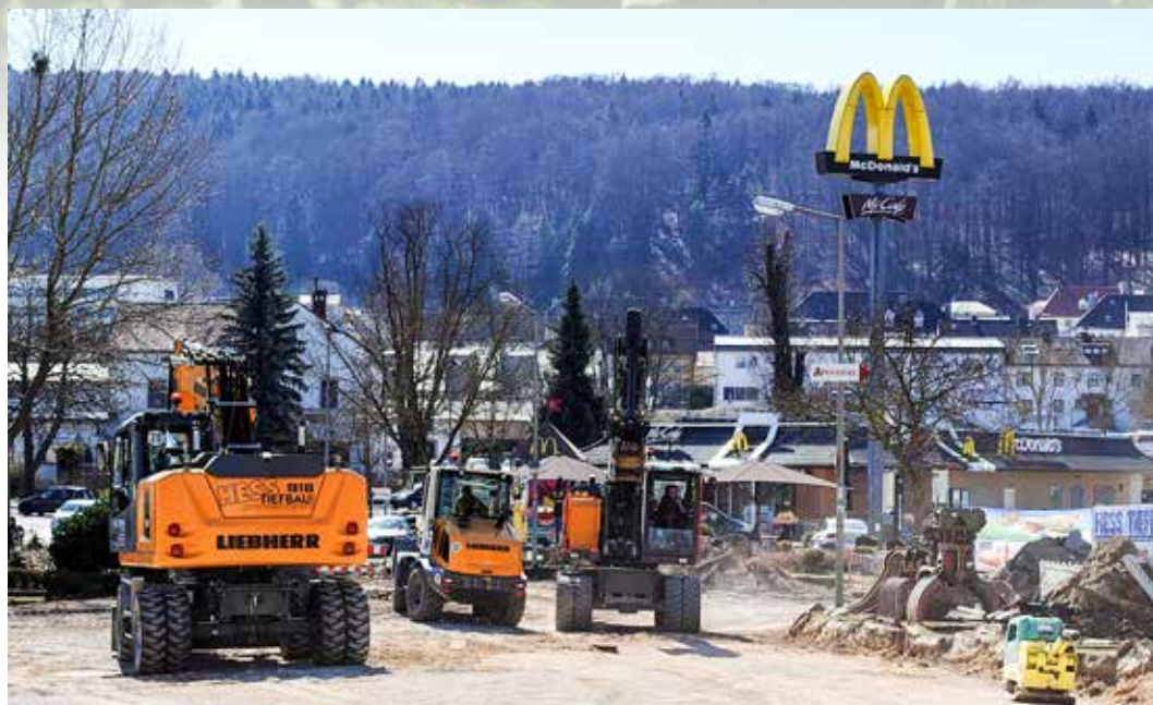
Beginn der Bauarbeiten rund um die Regensburger Straße
